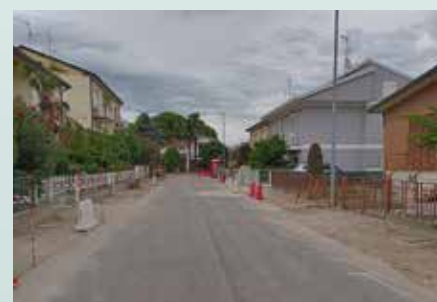
Lavori di sistemazione stradale a Godo
