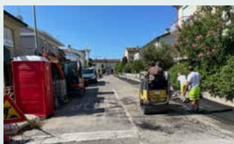
Manutenzione strade: asfaltature a Russi e frazioni
